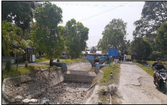
Fig. 2. Existing Condition Hm 00+00
