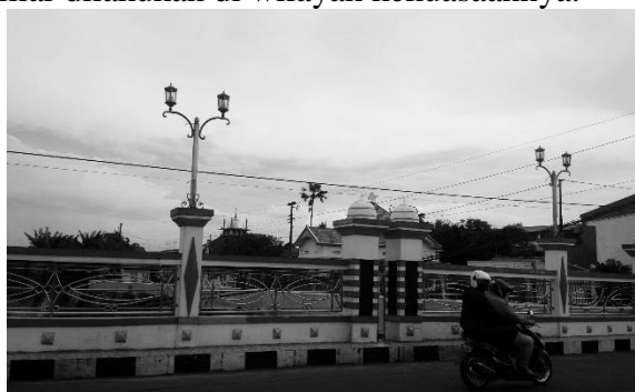
Gambar 19. Jembatan Kaligelis Pemisah Kudus Kulon-Wetan (Dokumen peneliti, 2020)
