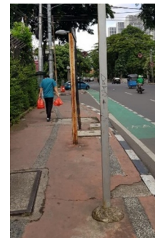
Gambar 31 Tiang listrik, telepon dll yang menghalangi jalan tidak ada jalur tunanetra
