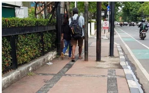
Gambar 30 Tiang listrik, telepon dll yang menghalangi jalan tidak ada jalur tunanetra
