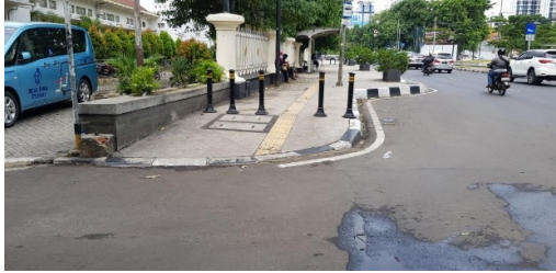
Gambar 34 Jalur khusus tunanetra terputus dan tidak menyambung dengan pedestrian sebelahnya Sumber: Dokumentasi penulis, Januari 2018
