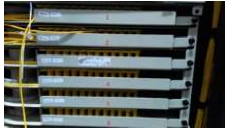
Gambar 3. Rak FTM Tampak Dekat
