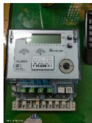
Gambar 4. Meter digital 3 fasa paska bayar
