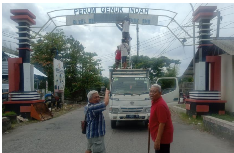
Gambar 4. Pemasangan papan informasi elektronik untuk wilayah kelurahan Gebangsari Semarang
