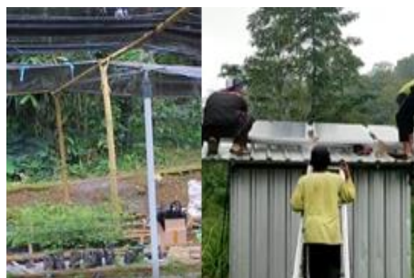
Gambar 4. Proses pemasangan panel kontrol PLTS dan kendali smart farming
