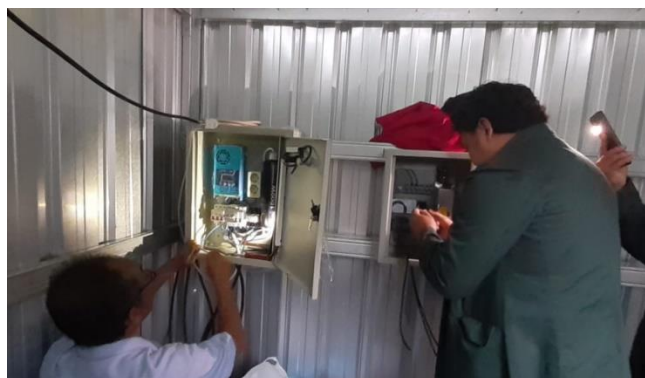
Gambar 3. Proses pemasangan panel kontrol PLTS dan kendali smart farming
