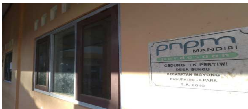
Gambar 1. Deskripsi gedung TK Pertiwi Desa Bungu
