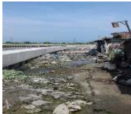
Gambar 4. Tumpukan sampah di saluran drainase
