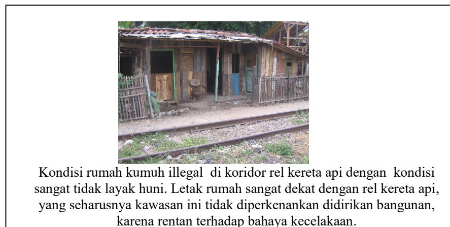
Gambar 7. Kondisi rumah kuuuh ilegal
